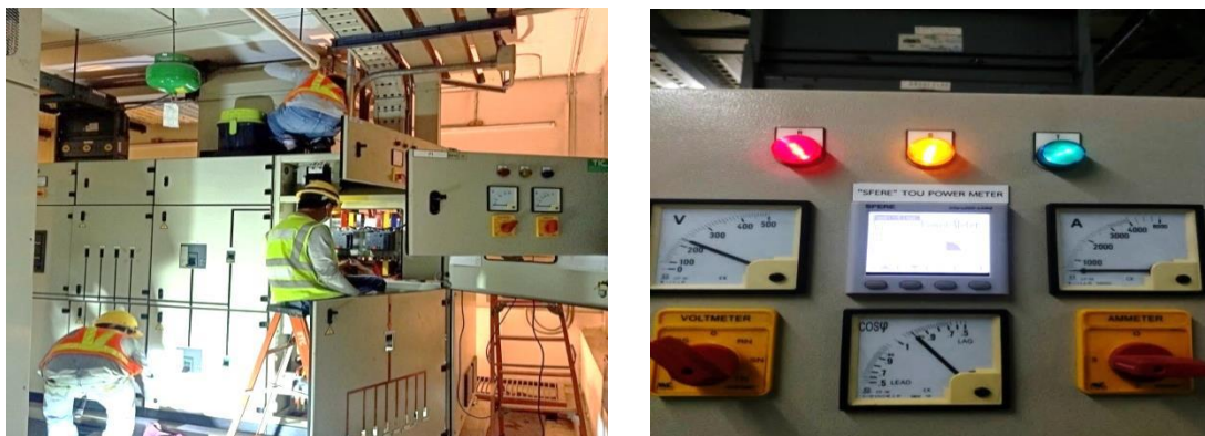
รูปที่ 3 การดำเนินงานติดตั้งติดตั้งอุปกรณ์วิเคราะห์การใช้พลังงาน (TOU Power Meter) เพื่อตรวจสอบการใช้พลังงานของระบบภายในอาคาร
