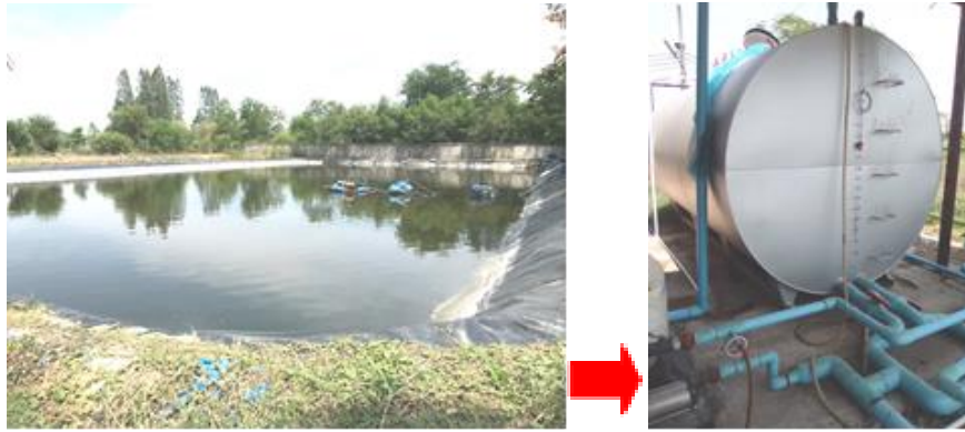
รูปที่ 10 การส่งน้ำจากบ่อเก็บน้ำสำหรับการผลิตไปยังถังเก็บน้ำเพื่อส่งเข้าสู่การผลิต
