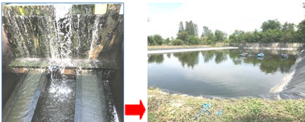
รูปที่ 9 การส่งน้ำจากบ่อวนตักการชะลอน้ำและเก็บสารแขวนลอยไปยังบ่อเก็บน้ำสำหรับการผลิต
