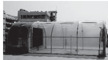
รูปที่ 4 การติดตั้งอุปกรณ์การทดลอง
