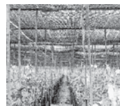
รูปที่ 1 โรงเรือนเสาไม้
