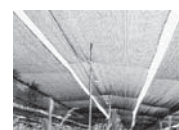
รูปที่ 2 โรงเรือนเสาเหล็ก
