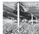
รูปที่ 3 โรงเรือนเสาคอนกรีต
