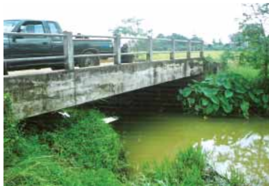
จุดที่ 5 บริเวณสะพาน ต. บ้านพร้าว
