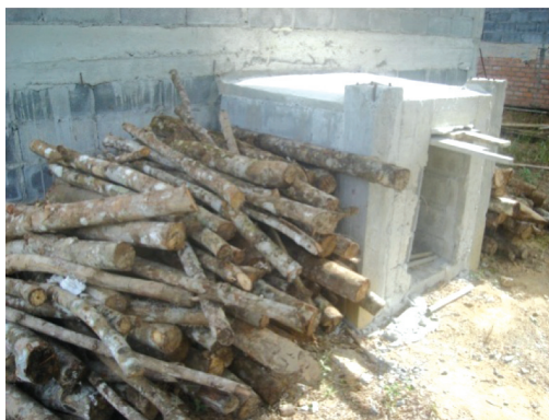
รูปที่ 3 บริเวณด้านหลังของโรงอบยางแผ่นดิบพลังงานร่วมแสงอาทิตย์และชีวมวล
