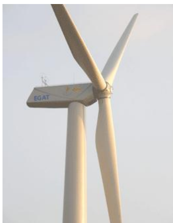
ภาพที่ 1 กังหันลมผลิตไฟฟ้า ณ อ่างพักน้ำตอนบนโรงไฟฟ้าลำตะคองชลภาวัฒนา [4]
