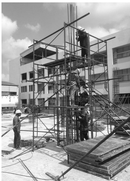
ภาพที่ 4 มาตรการความปลอดภัยในการทำงานติดตั้งเหล็กเสริมเสา
